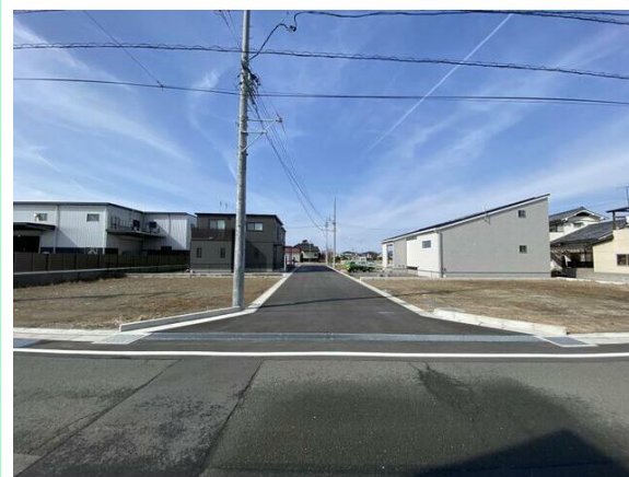
進入路：東より
